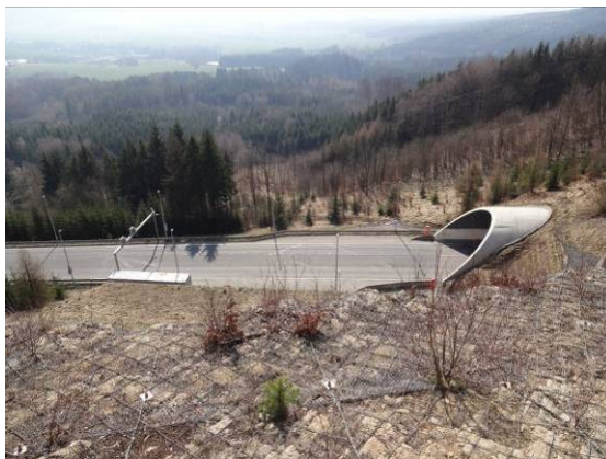
východní portál vč. sanovaného svahu po sesuvu z r. 2006 (mimo řů)
